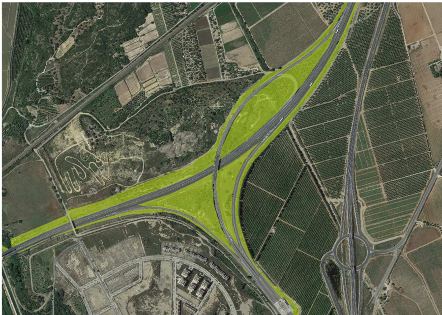
Figura 2. Exemple de superfície seleccionada com a apta en talussos i accessos a l'autopista AP7 al seu pas per Catalunya (accés AP7 de l'entrada/sortida núm. 41 Amposta/La Ràpita, municipi de l'Aldea)
