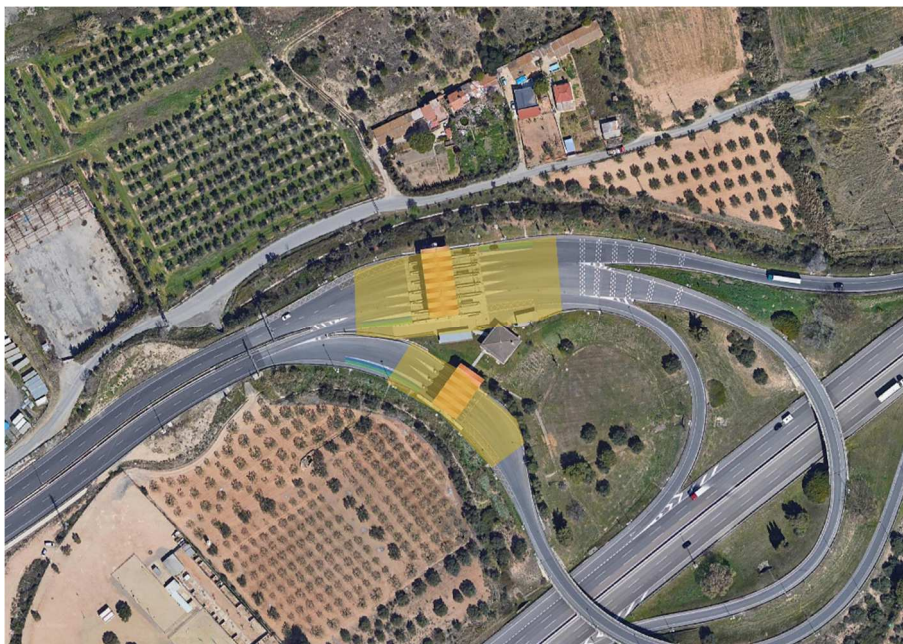
Figura 9. Exemple de superfície creada sobre àrees d'antics peatges de l'autopista AP7 (antic peatge de la sortida/entrada 34 Reus-Tarragona)
